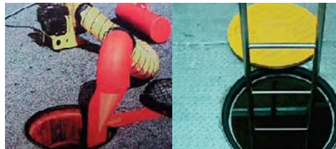
맨홀의 새들 덕트를 이용한 환기 방법
